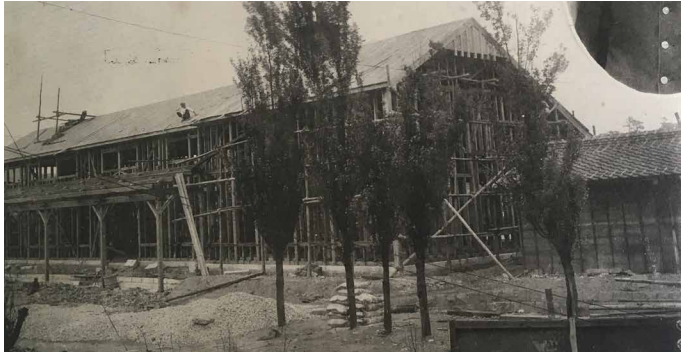
建設中の早岐駅(明治30年頃)
